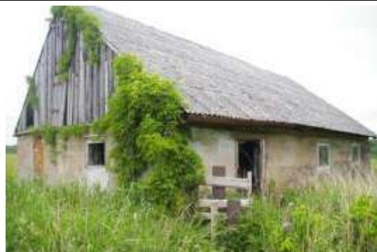
Kūts ēka ar kadastra apzīmējumu 6442 006 0014 004
