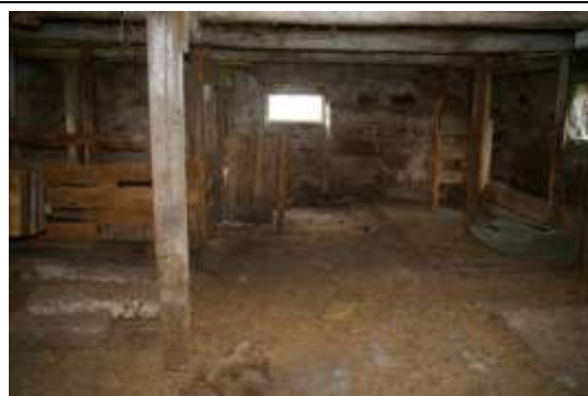
Kūts ēka ar kadastra apzīmējumu 6442 006 0014 004
