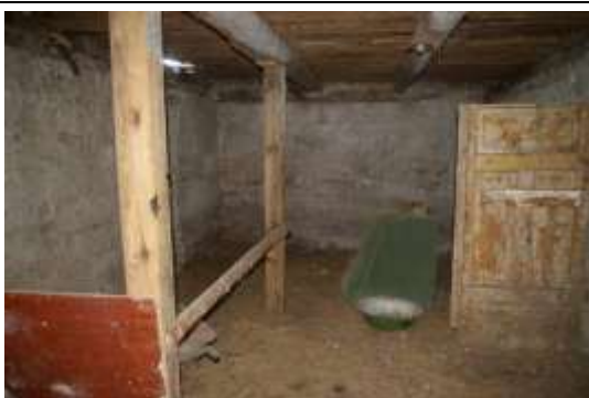
Kūts ēka ar kadastra apzīmējumu 6442 006 0014 004
